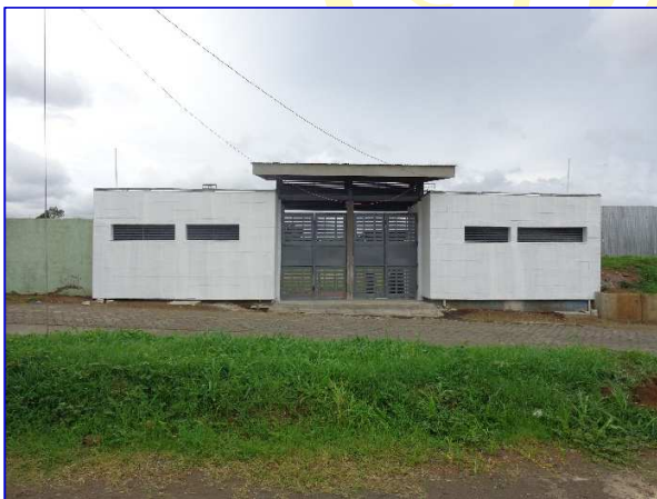
Portón de acceso noreste y servicios sanitarios para público N° 1.
